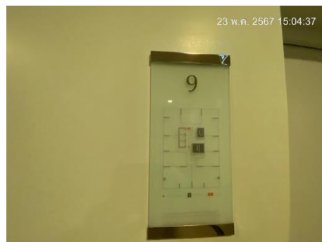
แปลนแผนผังแต่ละชั้นแสดงตำแหน่งห้องรวมถึงตำแหน่งที่ตั้งอุปกรณ์ดับเพลิง รูปที่ 2.1-16 ระบบการป้องกันและระงับอัคคีภัย (ต่อ)
