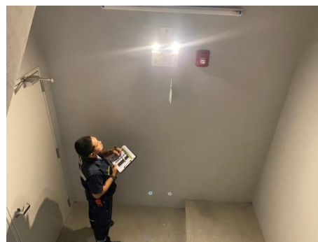
เจ้าหน้าที่ตรวจสอบเช็คการทำงานของไฟส่องสว่างฉุกเฉิน
