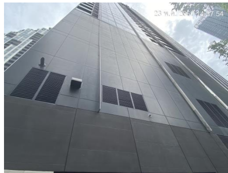
ระบบระบายอากาศของอาคาร
