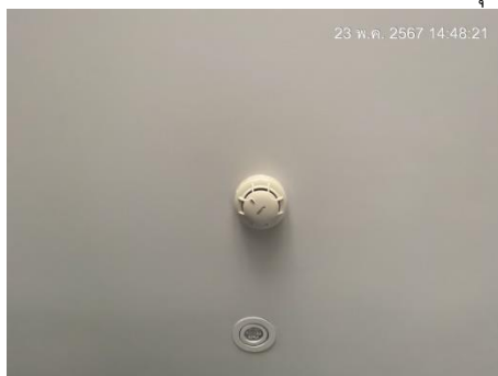
อุปกรณ์ตรวจจับควัน รูปที่ 2.1-16 ระบบการป้องกันและระงับอัคคีภัย
