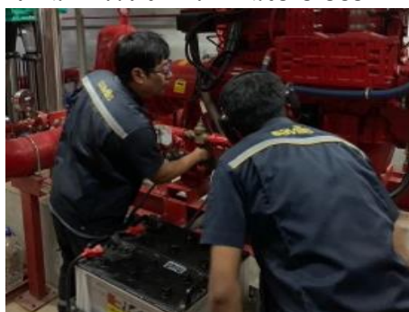
เจ้าหน้าที่ตรวจสอบเช็คระบบปั๊มสูบน้ำดับเพลิง
